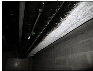
Photo N° 941 AMIANTE CIMENT -- COULOIRS -1 Gainés & coffres horizontaux Ventilation haute (Fibres-ciment)
